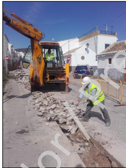
Lámina I: Detalle los trabajos de apertura de la zanja.
