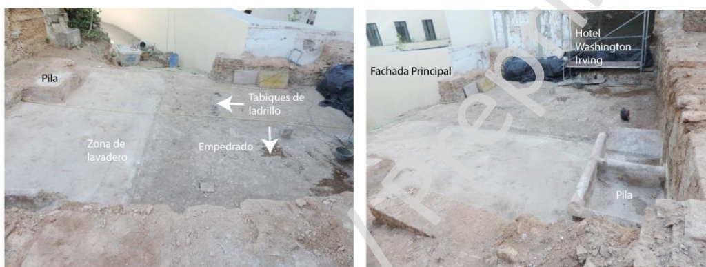
LAM V: Ubicación de las edificaciones desescombradas.
