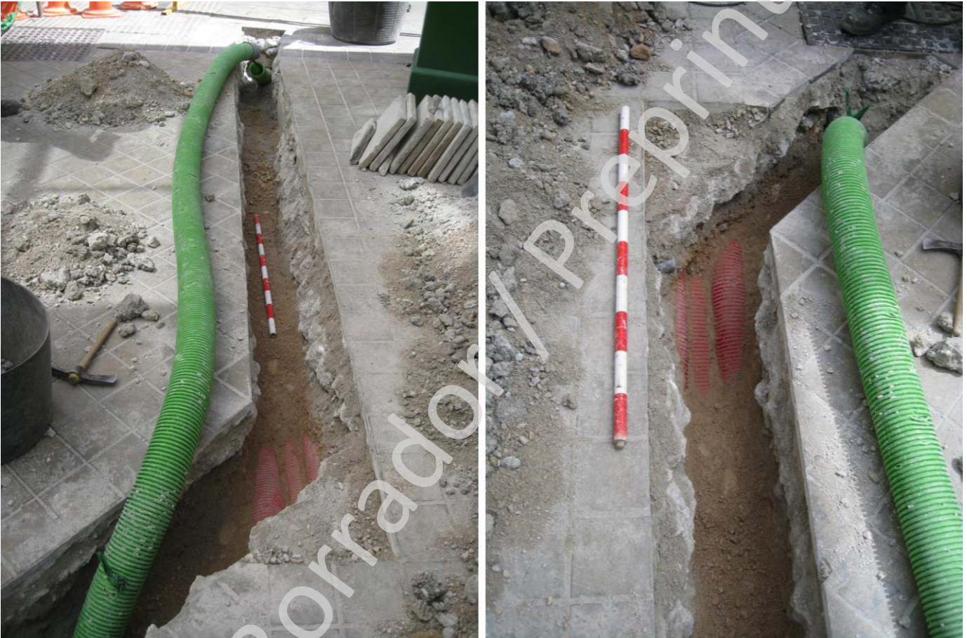
Ilustración 8: Resultado de la apertura de la zanja en sus 2 tramos.
