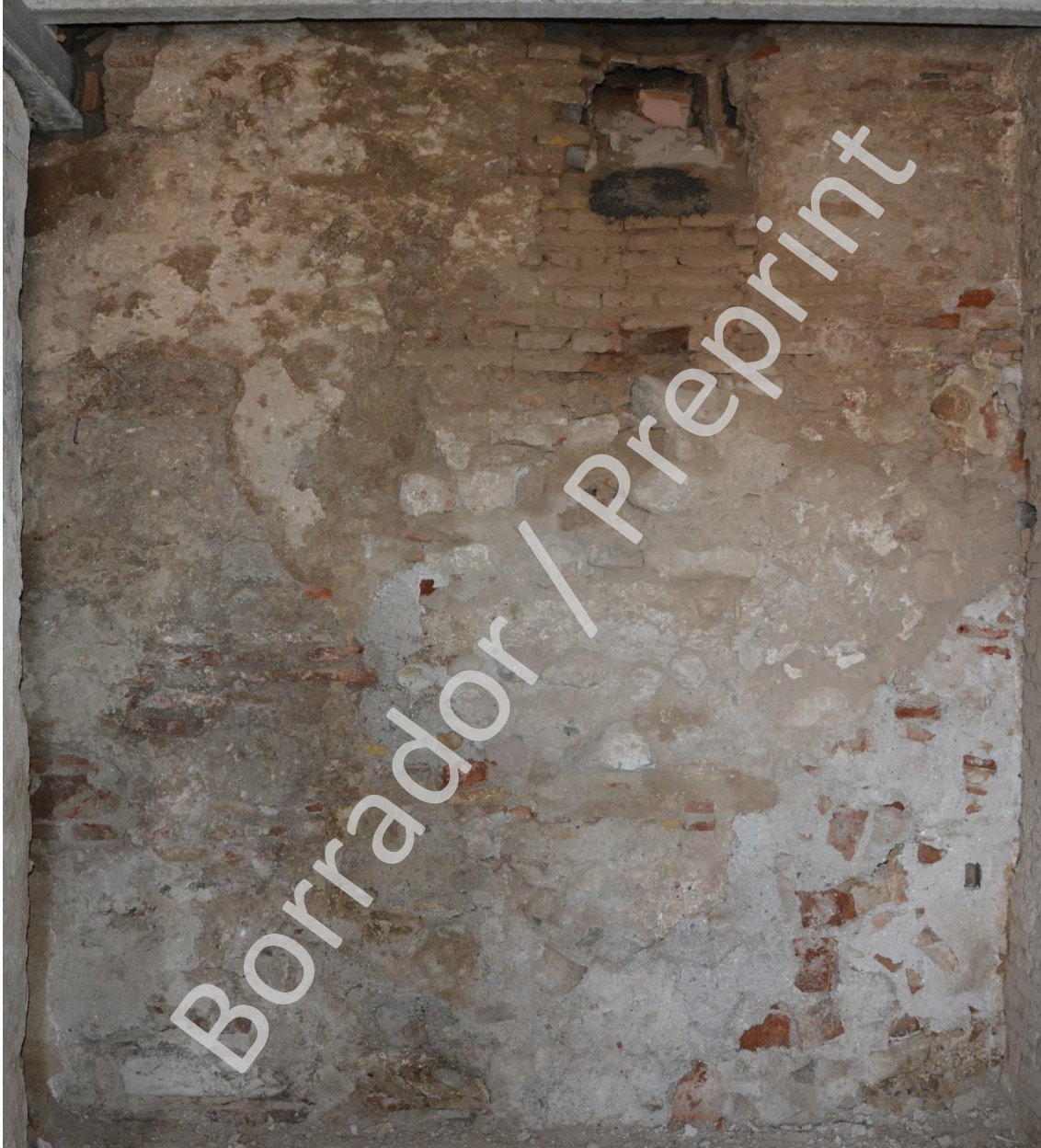
Muro interior, fondo de la edificación.
