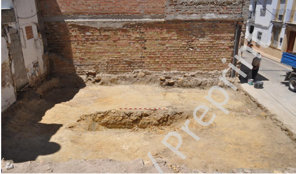
Lámina 7. Vista final del solar hacia el oeste.
