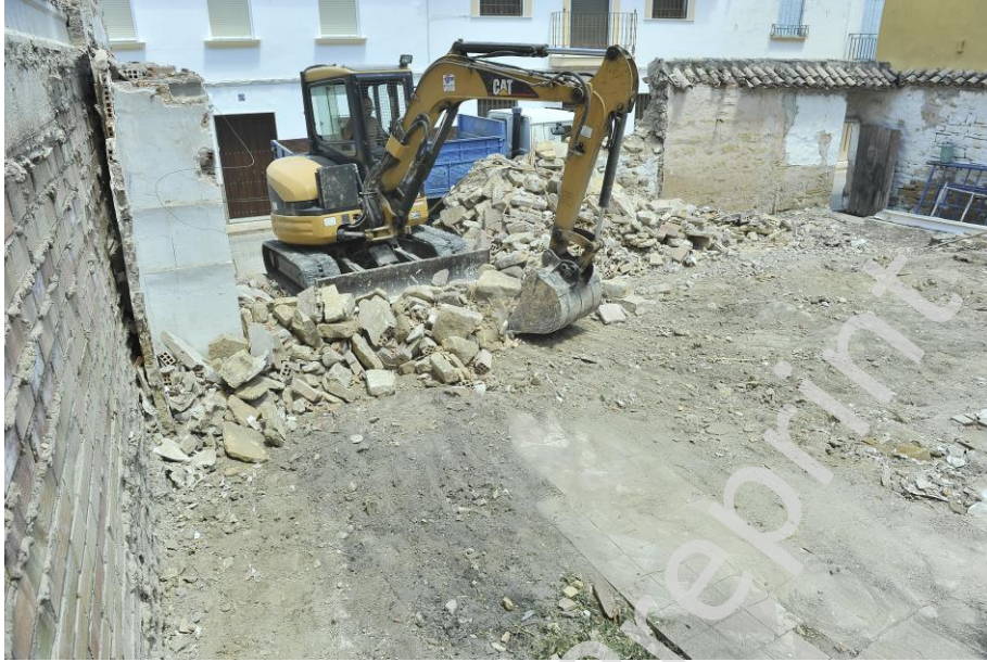
Lámina 1. Retirada de los escombros procedentes de la demolición.
