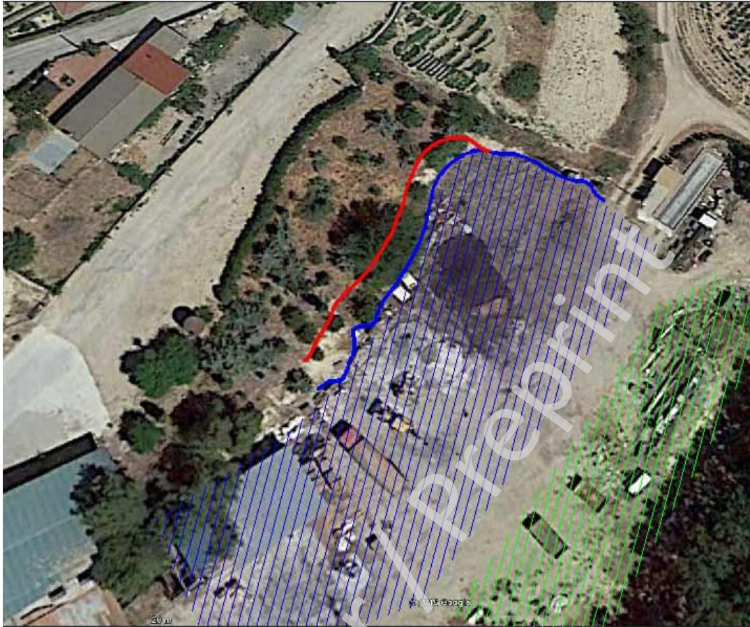
Ilustración 5: Explanada de la parcela. En sombreado azul, la zona llana conseguida tras el desmonte de la ladera. En verde, la plataforma conseguida tras el vertido de la tierra extraída durante el aterrazamiento. La línea azul señala el talud. La línea roja señala el lugar de retranqueo del talud.
