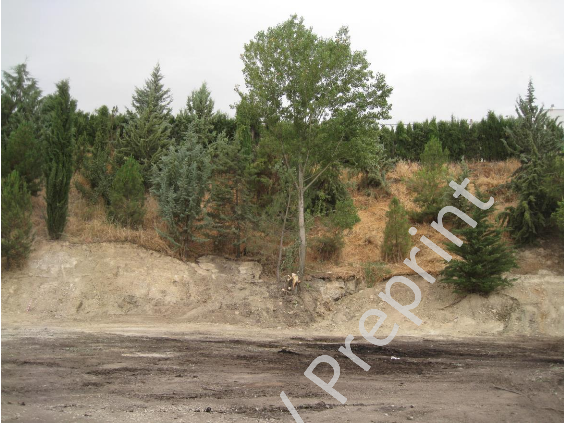
Ilustración 6: Limpieza del talud norte, en el lado noroeste(arriba) y noreste (abajo).
