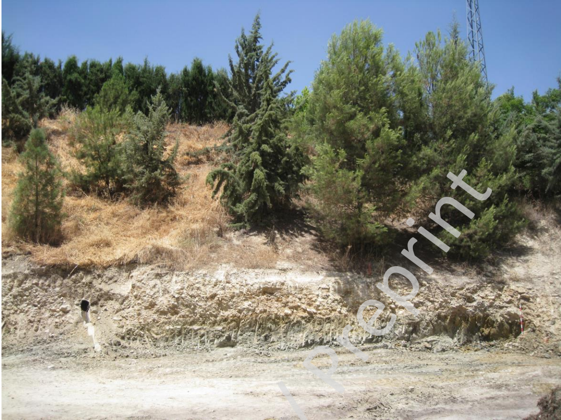
Ilustración 11: Tubería de desagüe público en el talud norte.
