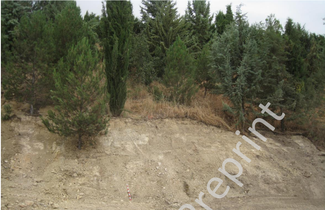
Ilustración 8: Detalle de la limpieza en el talud norte.
