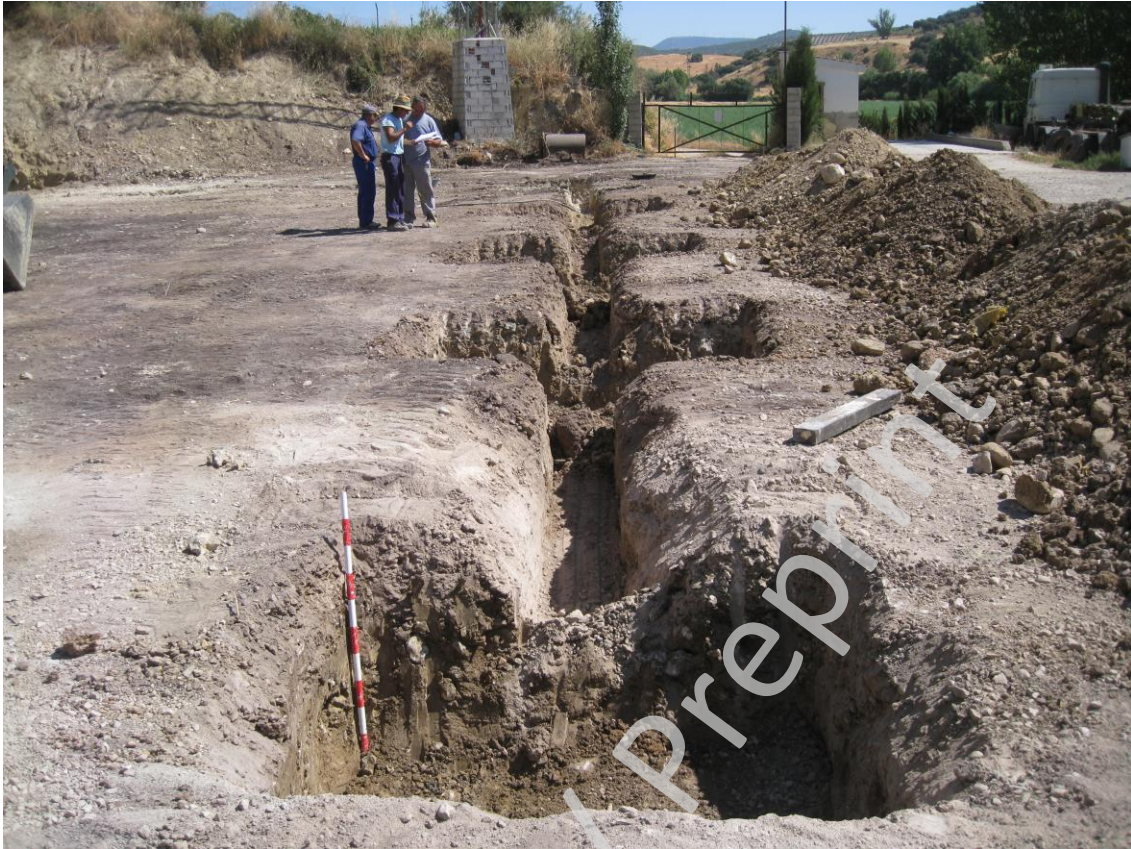
Ilustración 16: Zapatas y zanjas en el lateral sur.
