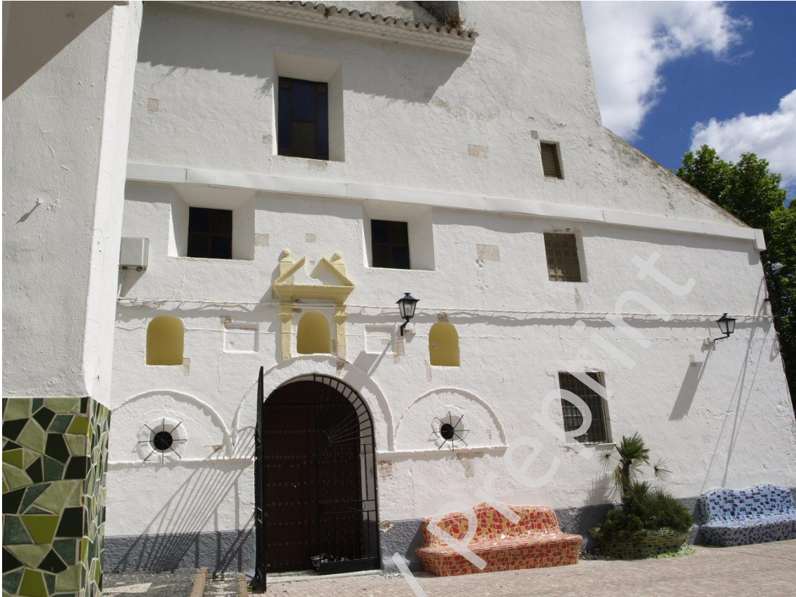
Lámina 1. Vista general de la fachada.
