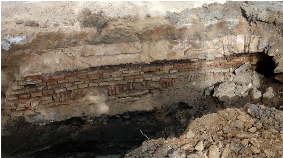
**Lámina V.** Detalle de la fábrica de ladrillos dispuestos a soga, tizón y canto
