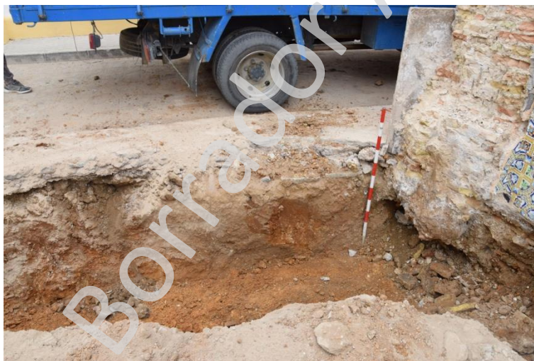
Figura 5. Detalle de la cimentación de la fachada donde se observa la presencia de las arcillas del sustrato casi en superficie.
