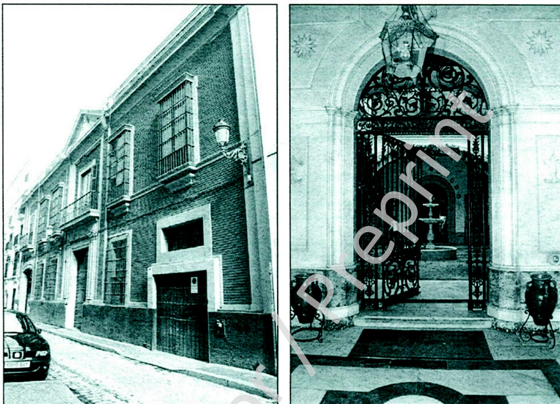
Lámina 1. Aspecto exterior del inmueble y zaguán de entrada, antes de la reforma
