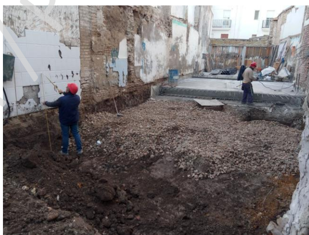
Fig.9. Finalización rebaje de cimentación
