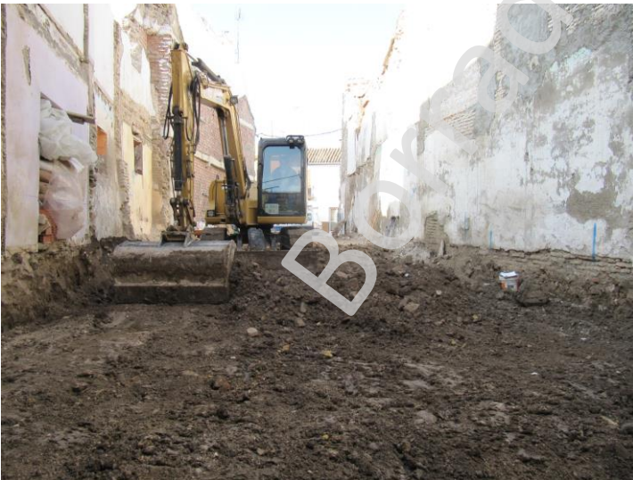
Fig. 4 y 5. Ejecución de la losa de cimentación
