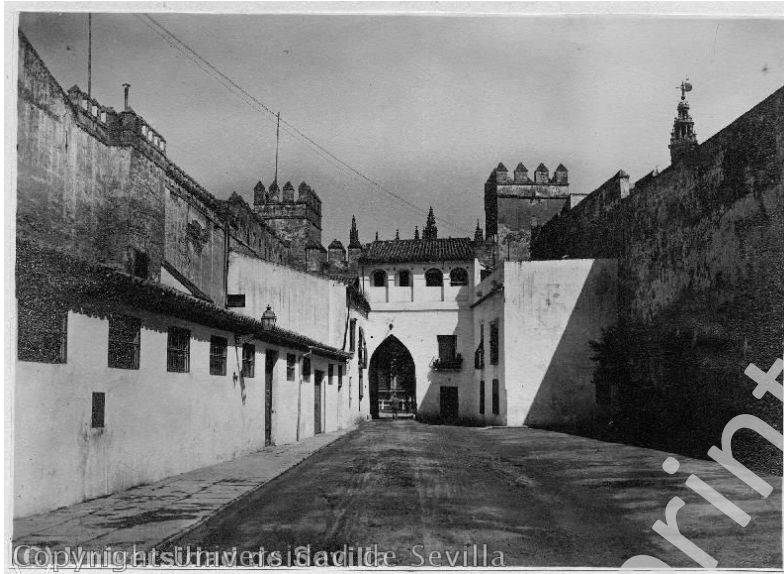
Figura 15. Vista del Patio del León hacia 1920. Obsérvese la presencia aún de las edificaciones secundarias adosadas a la muralla Oeste. Al Este sólo vemos adosada una casa a la muralla del recinto I que dista mucho de la visión que plantea el plano de Van der Borcht. Inicialmente pensamos que durante el paréntesis temporal que transcurre entre el s. XVIII y 1920 podrían haberse derribado las casas que parece que faltan. Sin embargo, los análisis arqueológicos efectuados en la base de la muralla Oeste (Tabales 2005) no sacaron a la luz indicios que pudieran corresponderse con restos de esas edificaciones, por lo que hemos interpretado que, al igual que pasó con otros proyectos diseñados para el Alcázar, como el de Vermondo Resta, éste tampoco llegó a ejecutarse tal y como está planteado en el plano. (Fototeca de la Universidad de Sevilla).
