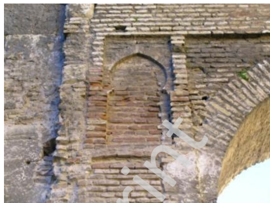
Figuras 8 y 9. Diferentes tipologías de arcos fabricados en ladrillo, localizados en la cara Norte de la Portada León-Montería. A la derecha, arcos entrelazados. A la izquierda arco túbido (Tabales 2007).
