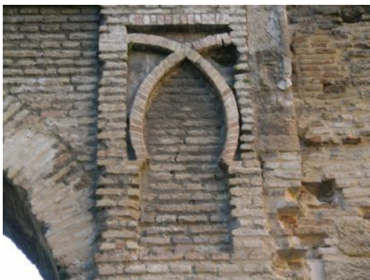
Figuras 8 y 9. Diferentes tipologías de arcos fabricados en ladrillo, localizados en la cara Norte de la Portada León-Montería. A la derecha, arcos entrelazados. A la izquierda arco túbido (Tabales 2007).
