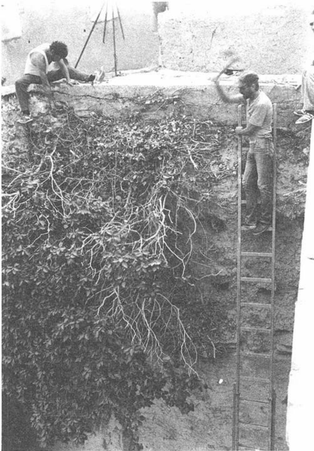
LAM. 2. La vegetación alcanzaba a veces un desarrollo excesivo: en la foto corte de la yedra que deterioraba el Muro de la Torre de la Vela.
