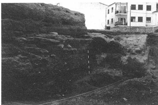
LAM. 2a. Torre de hormigón, foso relleno con los estratos fechados en los siglos XII-XIII y sobre el conjunto la muralla de tapial.
