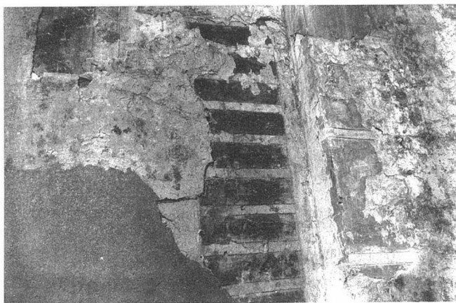
LAM.2. Detalle de la decoración de fachada de la calle Levías.
