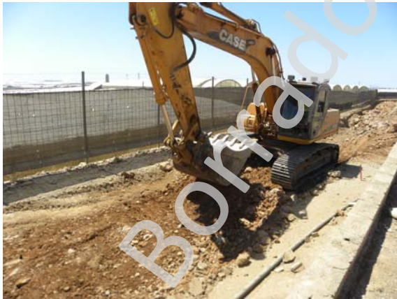
Fotografías 23-24: Apertura de zanja entre PK 9+500 y PK 9+975.
