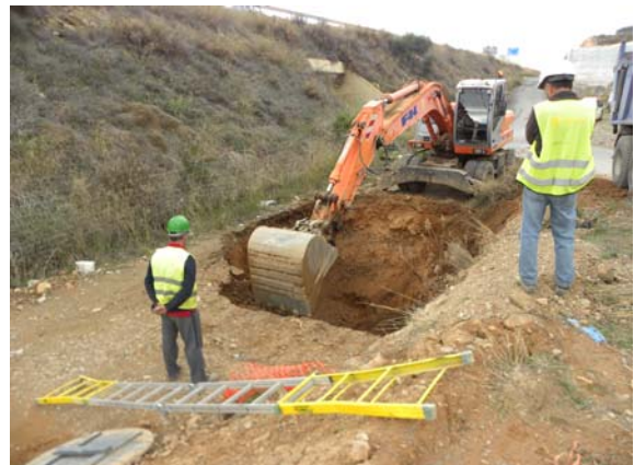
Fotografías 6-7: Trabajos de excavación en la hinca bajo la A-7.
