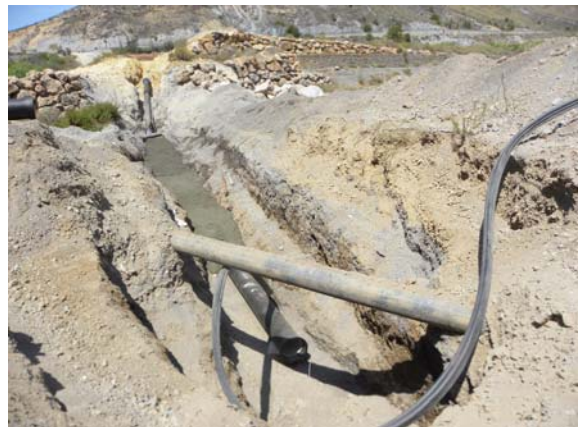
Fotografías 64-69: Trabajos de excavación junto a la carretera de Aguadulce (PK 30+400).
