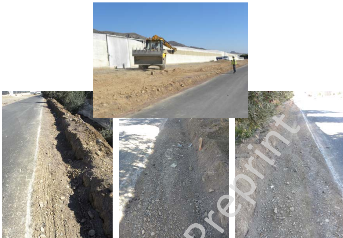
Fotografías 86-89: Excavación de cunetas en tramo G2.
