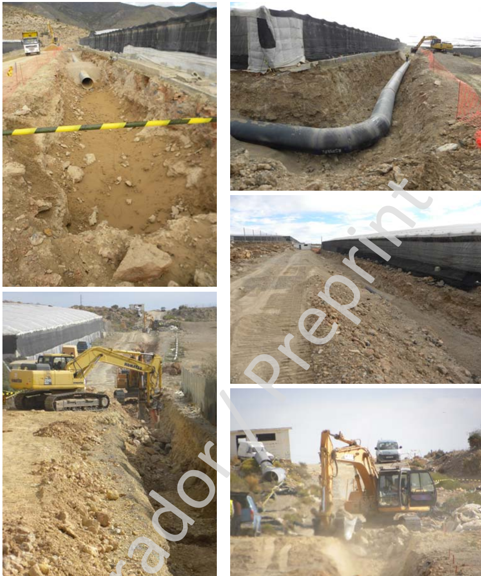
Fotografías 27-31: Trabajos de apertura de zanja entre el PK 12+500 y PK 13+500.
