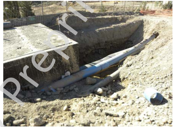
Fotografías 93-94: Excavación de arqueta, zanja y codo en PK 22+500.
