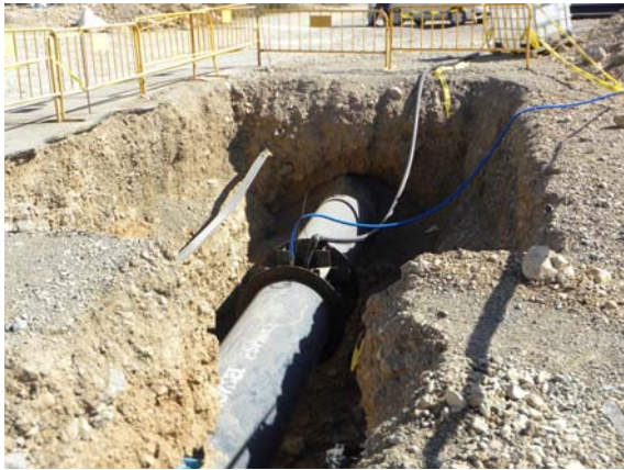
Fotografía 83: Arqueta en PK 13+900.
