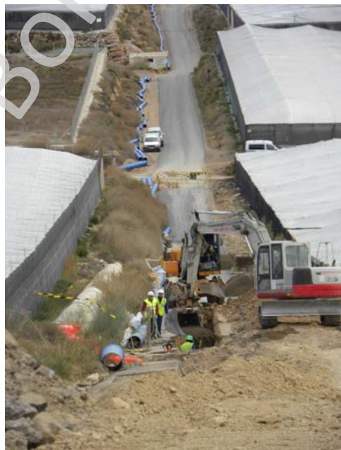
Fotografía 57: Vista General del tramo G3E
