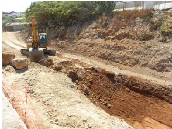
Fotografía 3: Apertura de zanjas entre PK 0+640 y PK 1+200.
