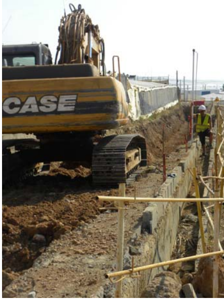
Fotografías 17-18: Apertura de zanja en el entorno del PK 4+500.
