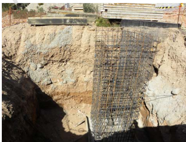
Fotografías 81-82: Arqueta en tramo G1.
