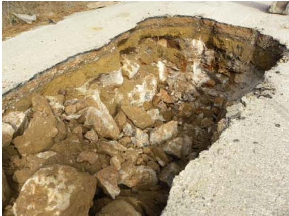
Fotografías 13-14: Trabajos de excavación y picado de roca en el tramo.
