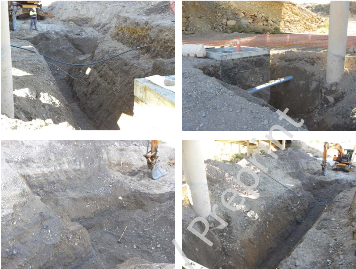
Fotografías 97-100: Arquetas y zanja en el PK 30+300.
