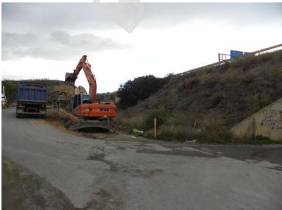
Fotografías 6-7: Trabajos de excavación en la hinca bajo la A-7.
