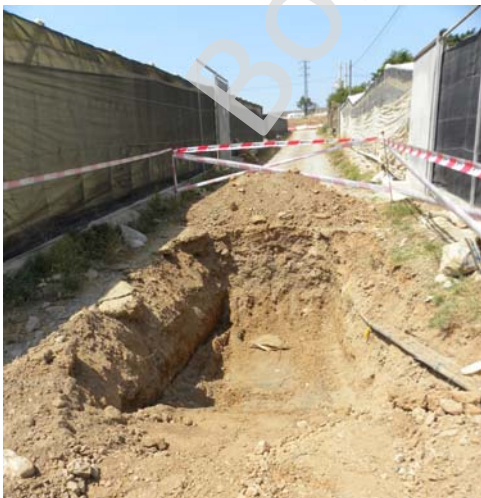
Fotografía 19: Cata en el PK 5+900.
