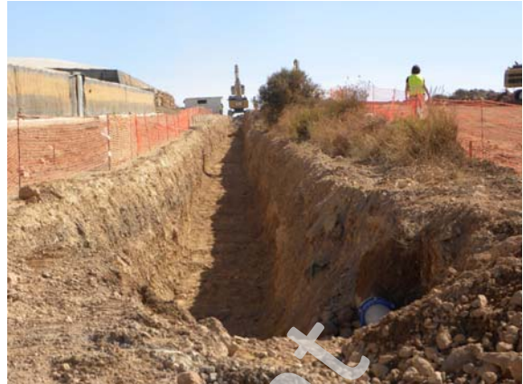
Fotografía 38: Zanja en el PK 16+760.
