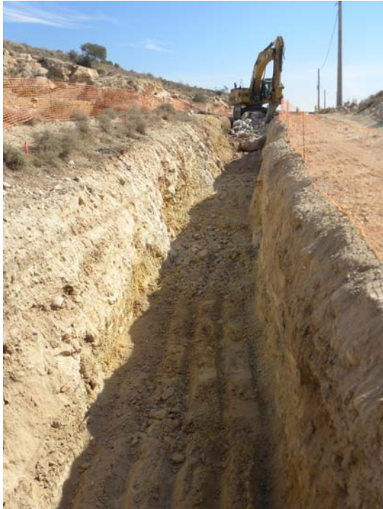
Fotografía 39: Zanja en el PK 16+220.
