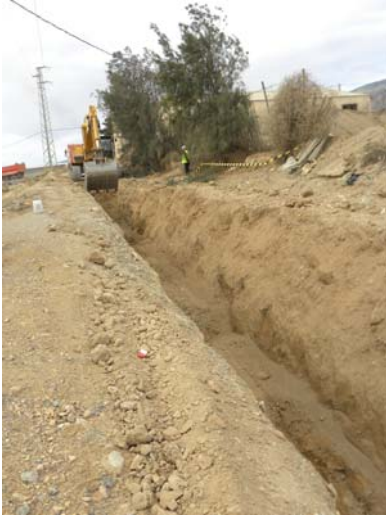
Fotografías 43-44: Apertura de zanja en el entorno del PK 18+500
