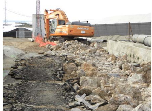
Fotografías 13-14: Trabajos de excavación y picado de roca en el tramo.
