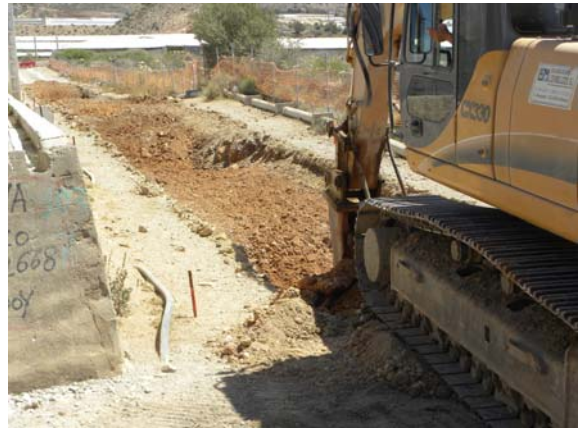
Fotografías 23-24: Apertura de zanja entre PK 9+500 y PK 9+975.
