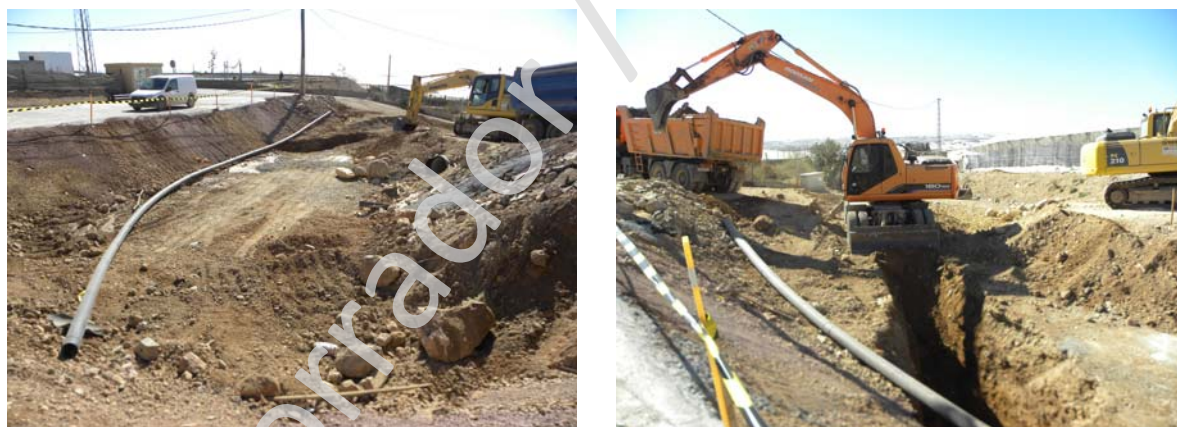
Fotografías 86-89: Excavación de cunetas en tramo G2.
