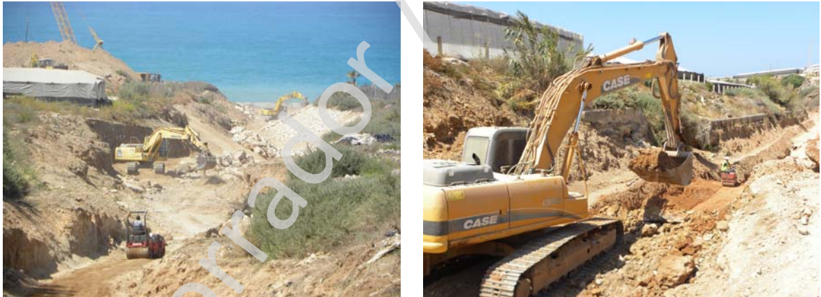
Fotografías 1-2: Desbroce y adecuación de taludes en el tramo I1A (entre PK 0+200 y PK 0+400).
