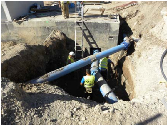
Fotografías 93-94: Excavación de arqueta, zanja y codo en PK 22+500.
