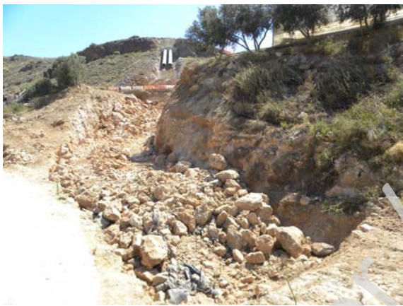
Fotografía 4: Trabajos de excavación en el tramo I1E.
