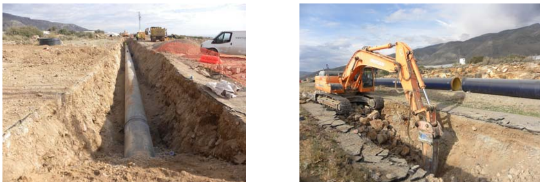
Fotografías 32-33: Excavación de la zanja en el tramo
