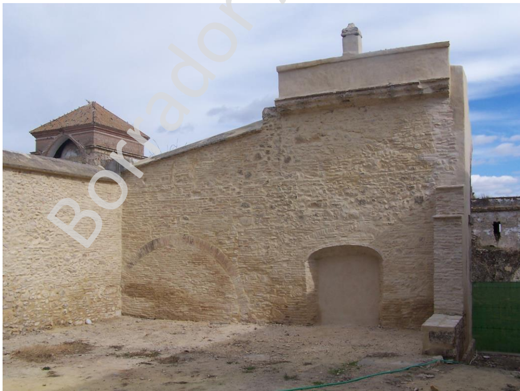
Lámina II: Vista de la estructura muraria después de su rehabilitación.
