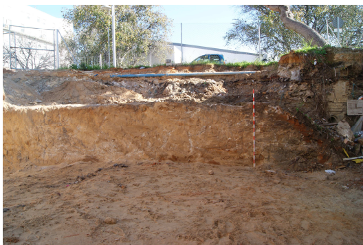
Muro de contención
