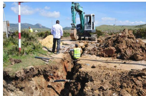
Lám. XXV a XXX. Trabajos de excavación de la zanja de acometida en el colector principal sur y su entorno.
