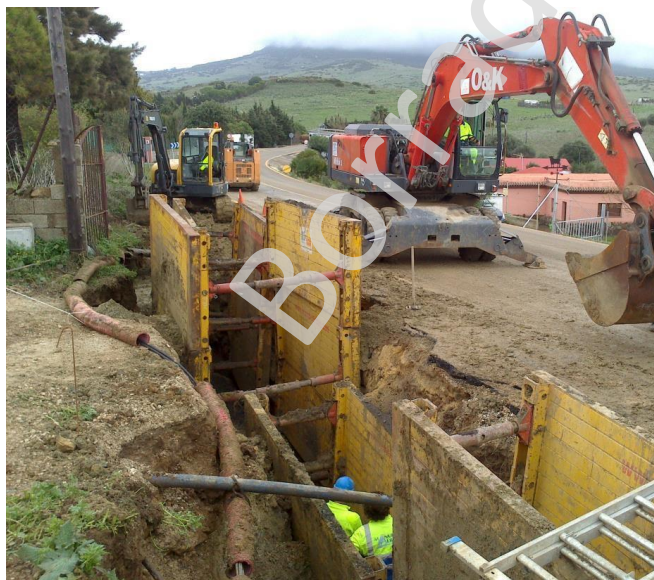
Lám. XVIII. Excavación del Colector Principal Norte en el entorno con el cruce con el colector 4.
