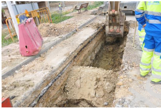
Lám. XX a XXIII. Algunos momentos de la excavación de la zanja del colector principal Sur.
