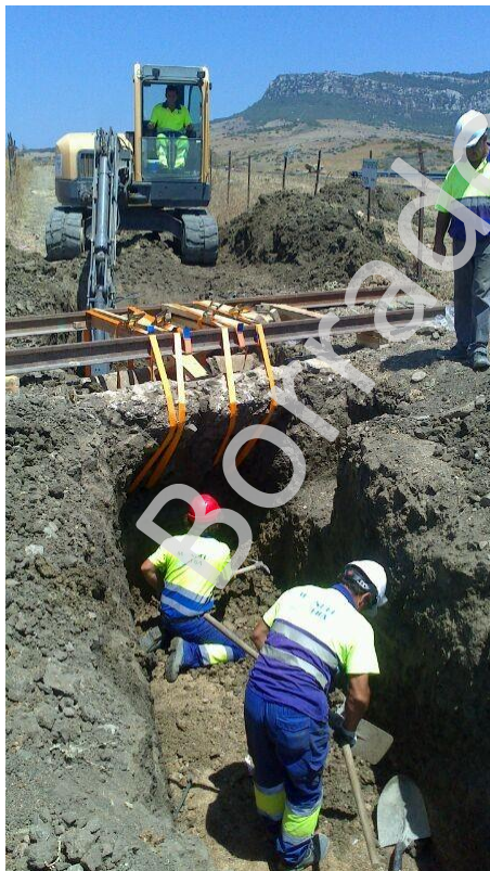
Lám. XVI y XVII. Trabajos de excavación y protección en torno al tramo de acueducto localizado en el sondeo 1.
