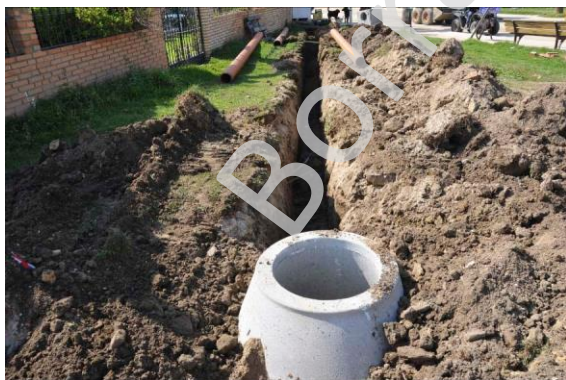
Lám. XXV a XXX. Trabajos de excavación de la zanja de acometida en el colector principal sur y su entorno.
