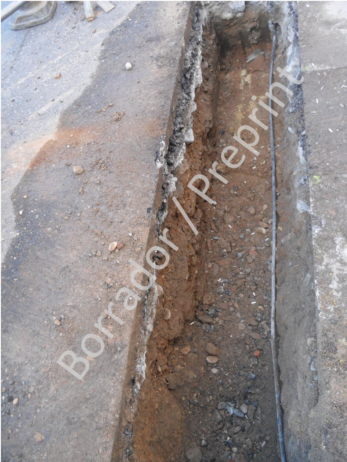
Lám I. Vista general del tramo de la zanja donde aparecieron los sillarejos
