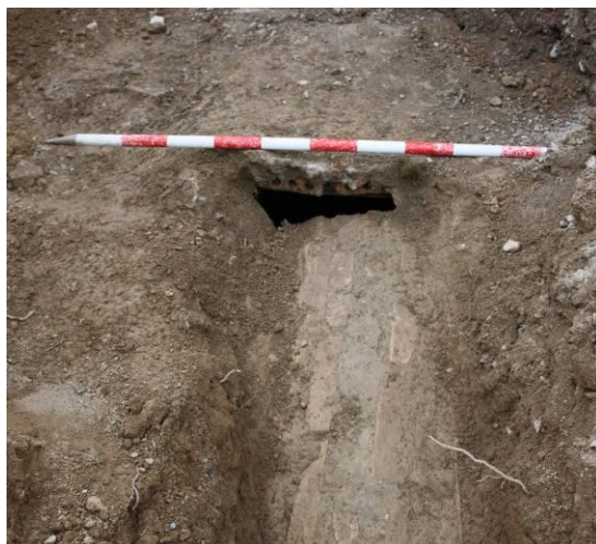
Foto 7: detalle de la unión de la misma con la arqueta de ladrillos huecos
