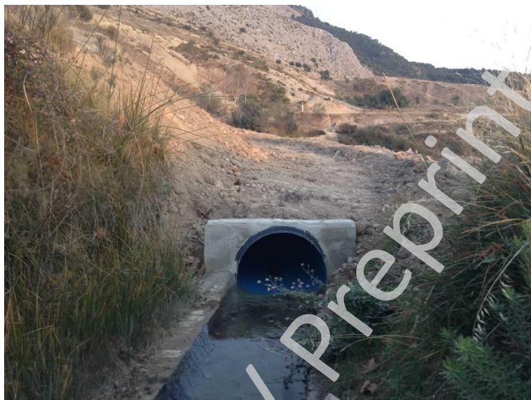
Foto 17: estado final de la entrada del tubo de PVC
