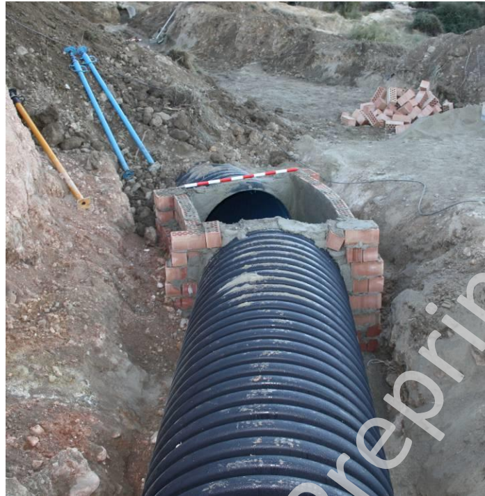
Foto 11: detalle de una de las arquetas
