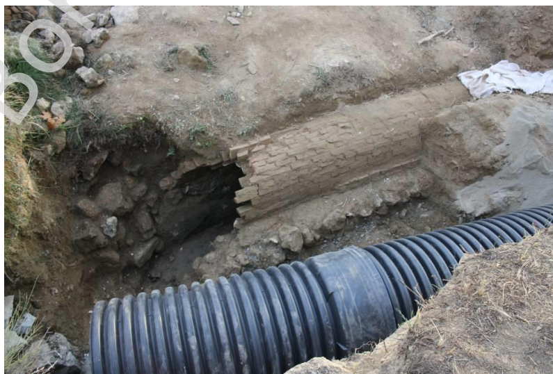
Foto 16: Instalación del tubo de PVC paralelo a la bóveda
