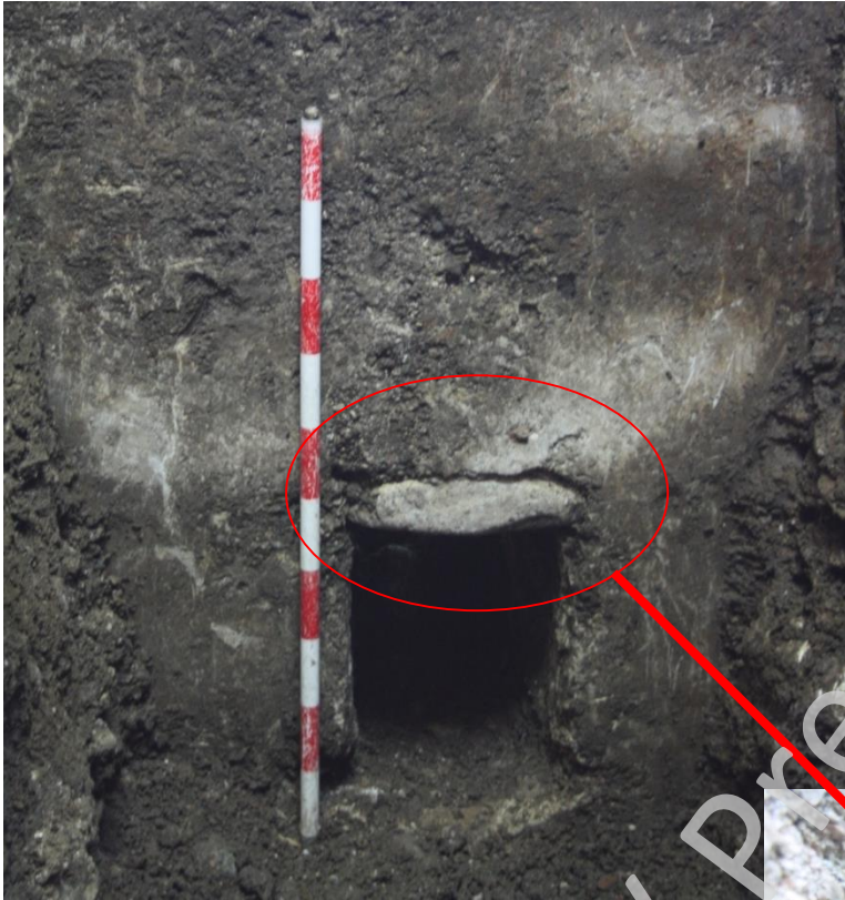
Detalle de la salida de aguas original de la muralla, en su cara interna. En la foto inferior se observa un detalle de la cubierta de piedras de la atarjea.
