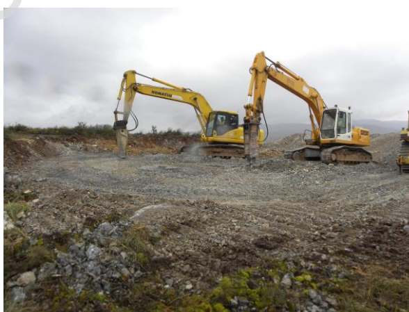
Figura 5: Plataforma y Cimentación Aerogenerador 02
