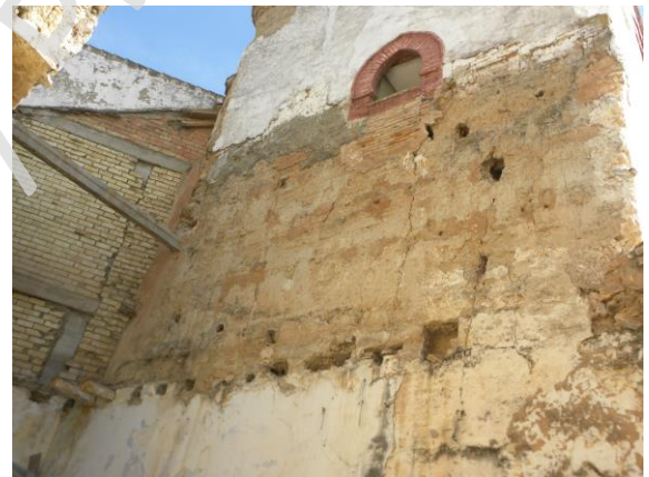
VISTA GENERAL Y DETALLES DEL ESTADO ACTUAL DEL ALZADO DE LA TORRE
