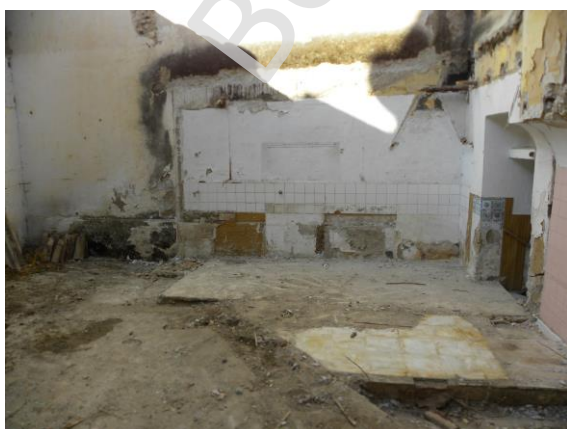
ESTADO FINAL DEL PATIO TRASERO
