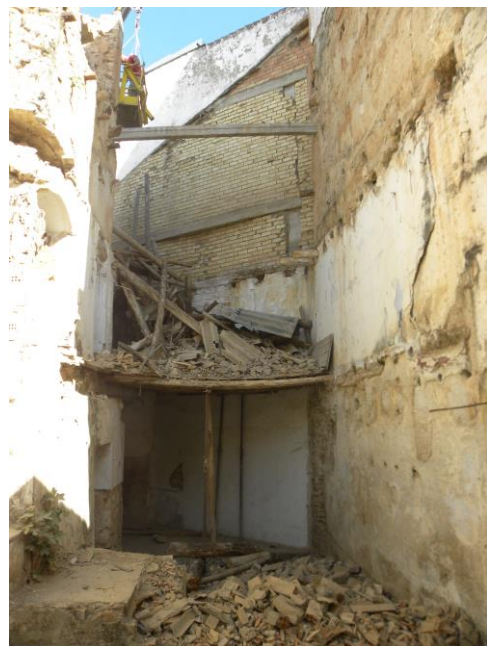
PROCESO DE RETIRADA DE ESCOMBROS, VIGAS Y ELEMENTOS SUELTOS
