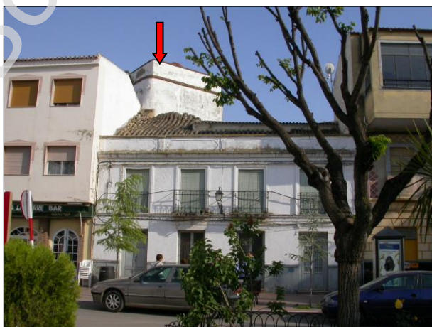
VIVIENDA Y TORRE EN PLAZA ANDALUCÍA Nº6
