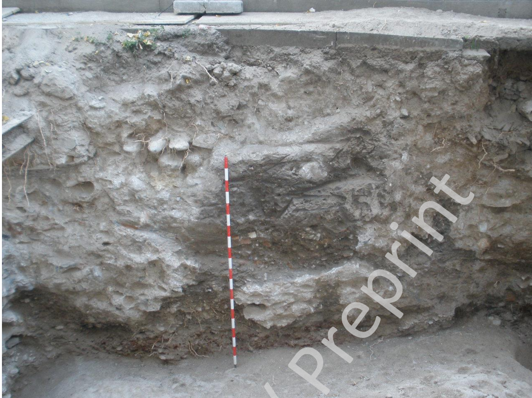
Lam. 14. E. 3.2 Lateral sureste de la cimentación
