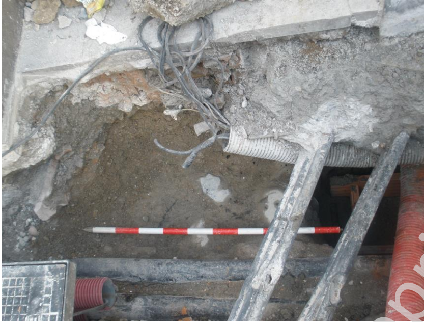
Lam. 21. Parte de estructura que delimita la cimentación documentada en el interior.
