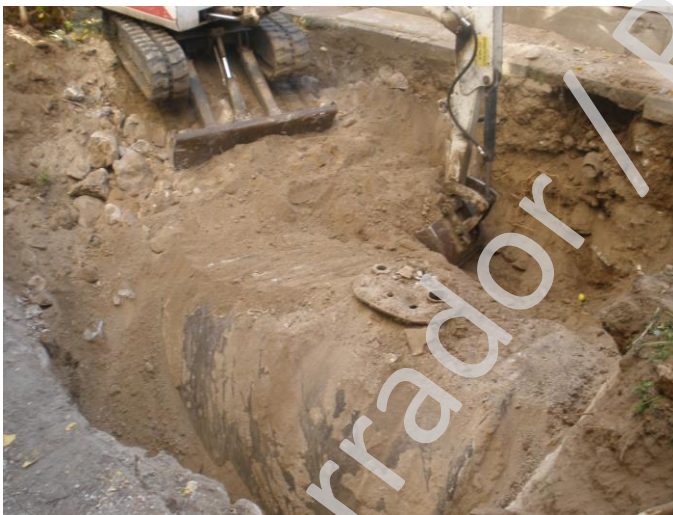
Lam. 8. Excavación del depósito de gasoil (U.E.C. 4)
