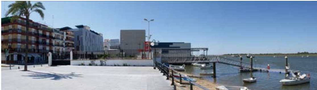
Fábrica de hielo y suministro de combustible al sur de las instalaciones pesqueras (2012)
