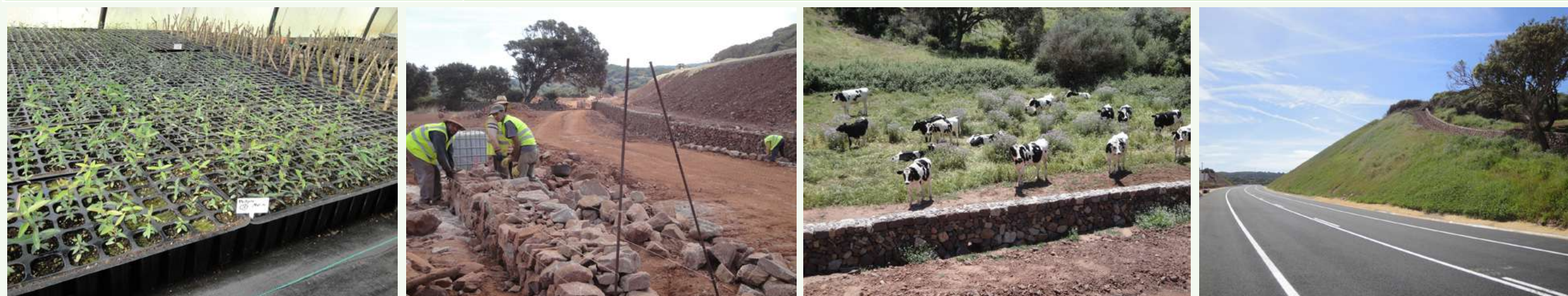
Fotos de la obra civil de la variante de Ferrerías en la Reserva de la Biosfera de Menorca
