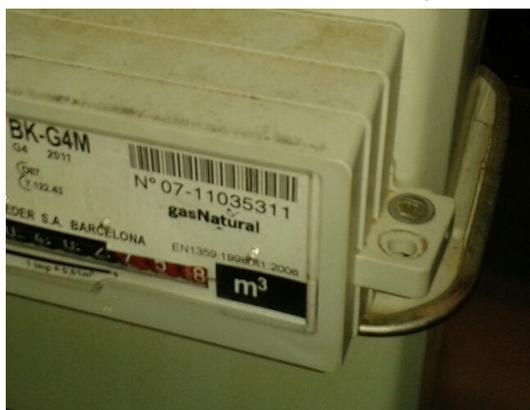
A continuación se observa el precinto del indicador mediante precinto del tornillo que lo sujeta y de la carcasa mediante la colocación en el tornillo que une las dos piezas de la carcasa con un cable metálico plastificado sujeto con una machihembrada.
