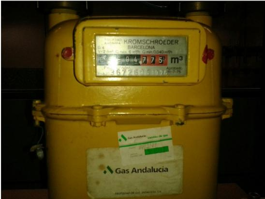
Los precintos que aseguran que la instalación no ha sido manipulada pueden ser: un cable metálico plastificado sujeto con una pieza machihembrada o un cable metálico plastificado sujeto con un precinto giratorio de mariposa. La posición habitual es en la conexión del contador con la tubería.
