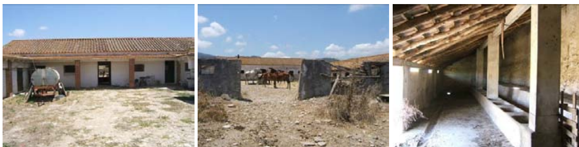
El Cortijo del Bálsamo, en estado de semiabandono, se estructura en torno a dos grandes patios, el de ingreso y el posterior. Asociadas al segundo de ellos tienen lugar una serie de cuadras, que sugieren una intervención donde el mundo del caballo tenga especial protagonismo.
