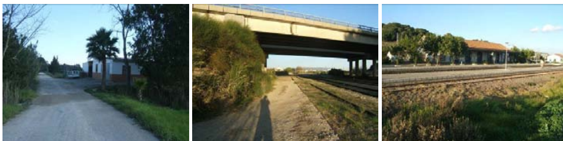
El Cordel de Algeciras , así como la conexión del Cordel del Paso de La Grulla con la estación de ferrocarril de Los Barrios, la cual discurre bajo puente de la A-381.
