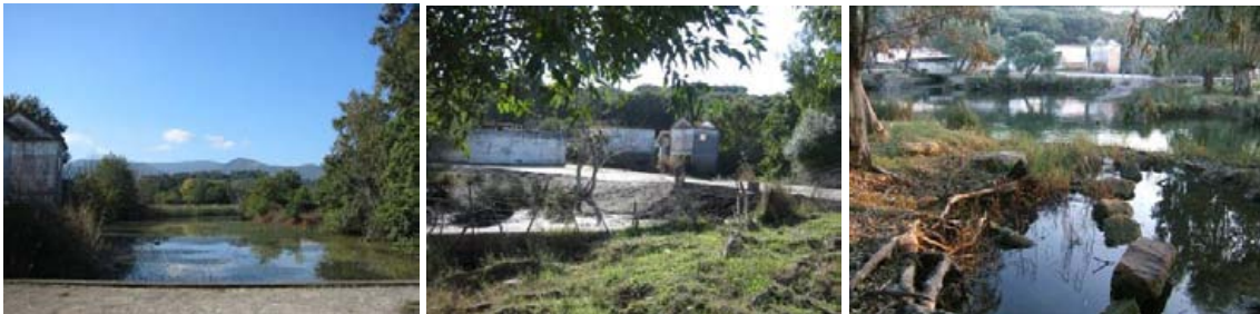
Estado actual del azud del arroyo Botafuegos
