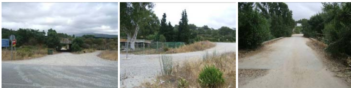
Situación actual. Encuentro con la C-440, el descansadero del Paso de La Higuera con infraestructuras que usurpan el dominio público y el puente sobre el Palmones que requiere de adecuación y protecciones.
