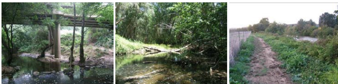
Estado de degradación de algunos tramos del cauce y la ribera correspondientes tanto al curso medio como al bajo.
