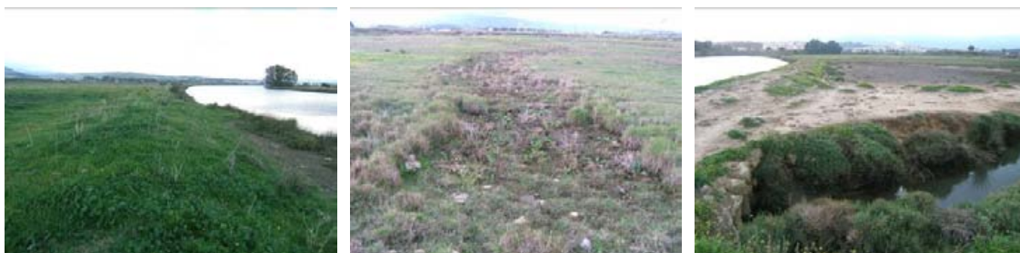
Aspecto del dique existente en la "Vega Mediana", el cual discurre asociado a la margen izquierda del río. También puede observarse uno de los caños cegados por el dique, así como el "Río Blanco", precariamente conectado con el Palmones, que constituye el principal caño de irrigación de esta marisma transformada.
