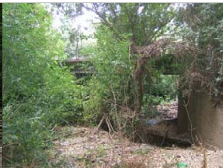
1. Entorno bajo el puente
