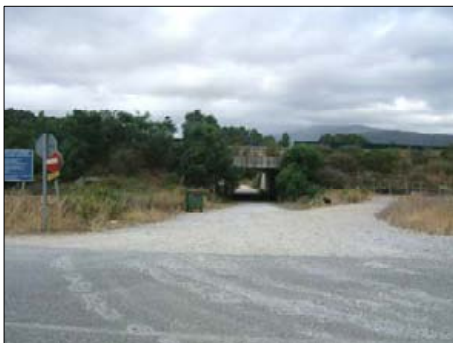
1. Puente de la Vega_ acceso
