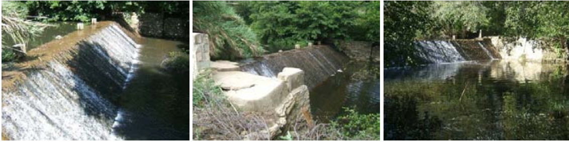
Estado actual del azud del arroyo Raudal
