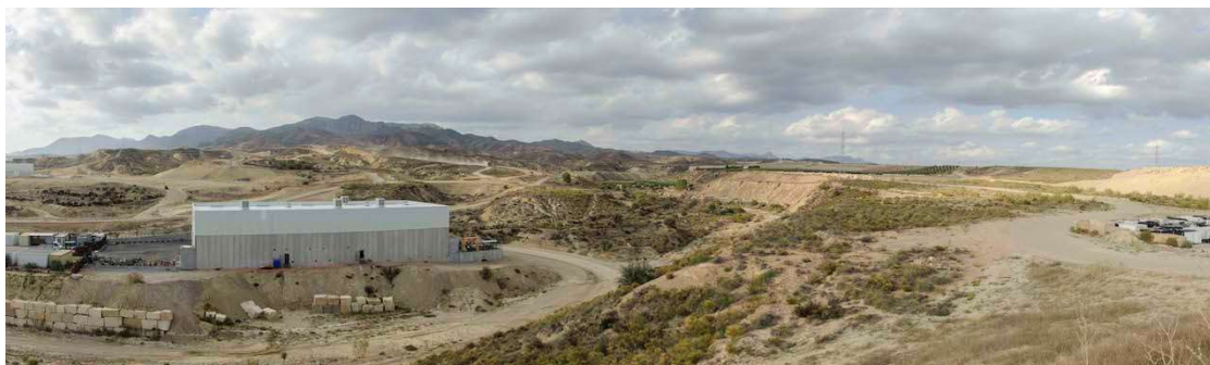
Vista general desde la zona este
