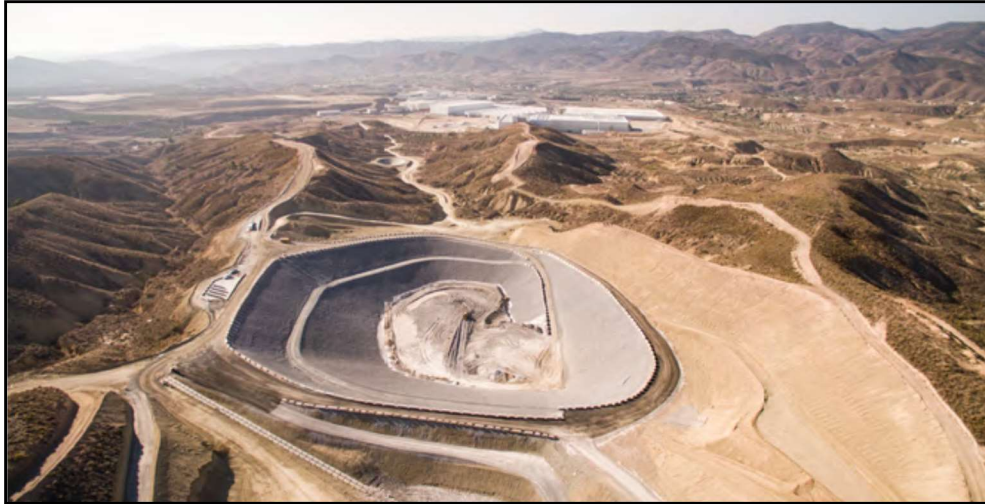
Imagen Nº2: Instalaciones de la planta de gestión y valorización de residuos.
