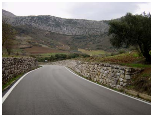
Antiguo muro de contención. Adaptación al paisaje
