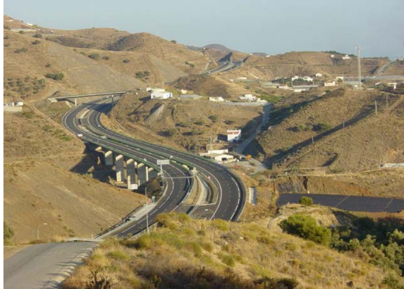
Autovía del Mediterráneo
