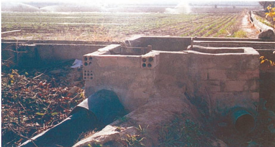
Figura 5. Arqueta de distribución dotada de varias salidas de agua a parcela.
