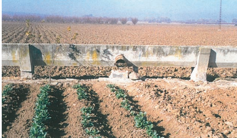
Figura 3. Toma de agua desde una acequia a parcela.
