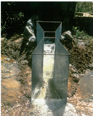
Figura 15. Aforador Parshall instalado para medir el caudal a la entrada de un tablar.
