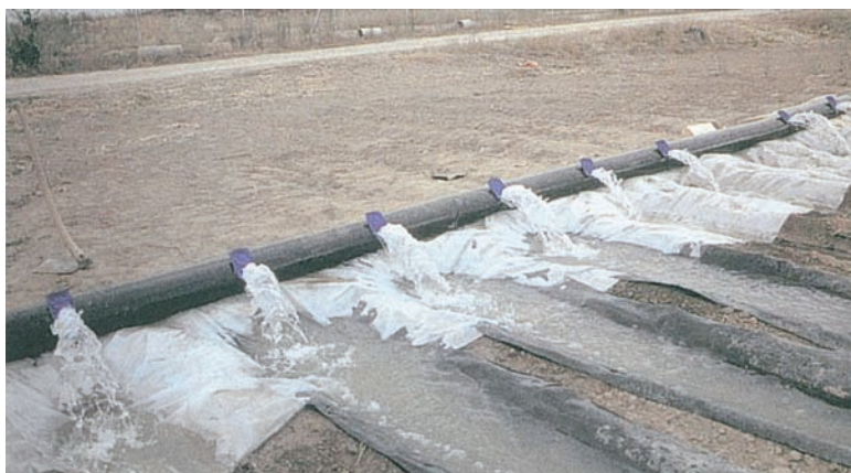
Figura 10. El suelo queda protegido del impacto de los chorros colocando unos simples plásticos.
