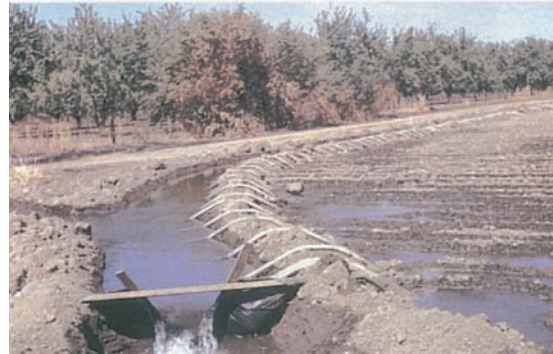
Figura 10. Barrera en una acequia con objeto de mantener un nivel de agua adecuado.
