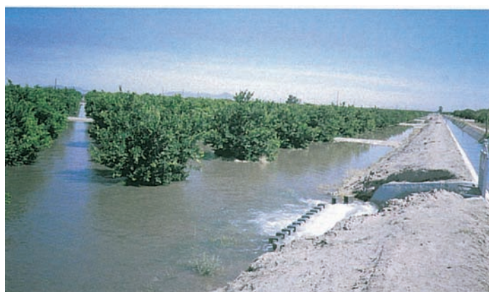
Figura 3. Estructura para evitar la erosión en cabecera consistente en dados de hormigón situados en la entrada de agua.
