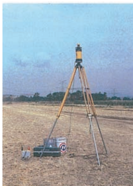
Figura 4. Emisor de láser colocado sobre su trípode, listo para comenzar el trabajo de explanación del campo.
