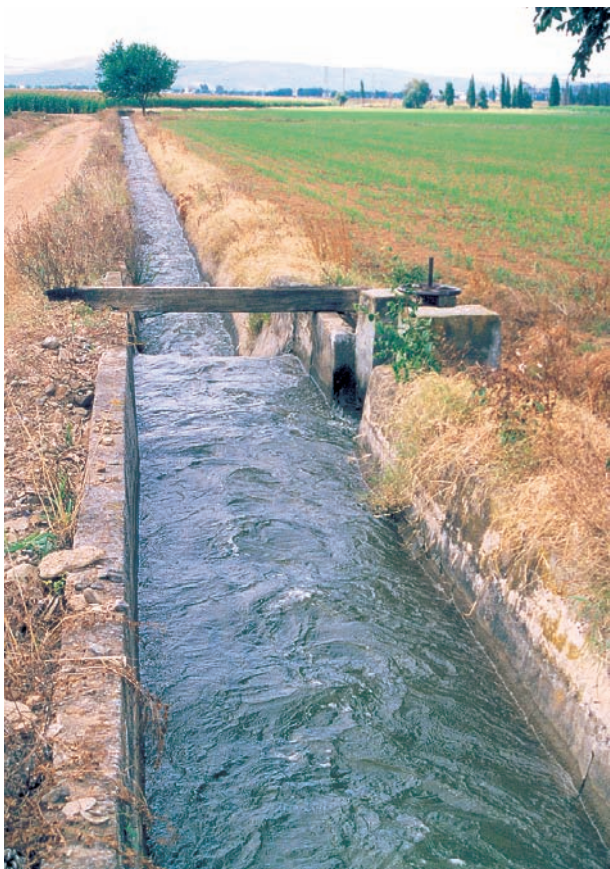
Figura 5. El agua suele llegar a la parcela mediante un sistema de distribución formado por canales o acequias.
