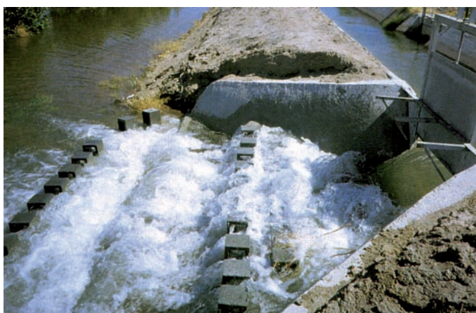
Figura 5. La aplicación del agua a un gran tablar de riego por superficie en forma de avenida como el de la figura, puede provocar un serio riesgo de erosión.
