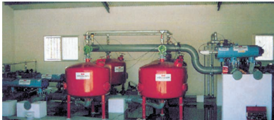
Figura 14. Cabezal de riego localizado.
