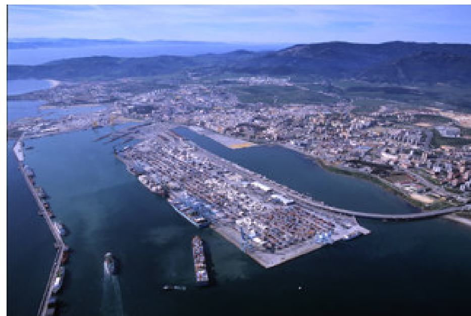
Vista aérea de la Bahía de Algeciras. Muelle Juan Carlos I
