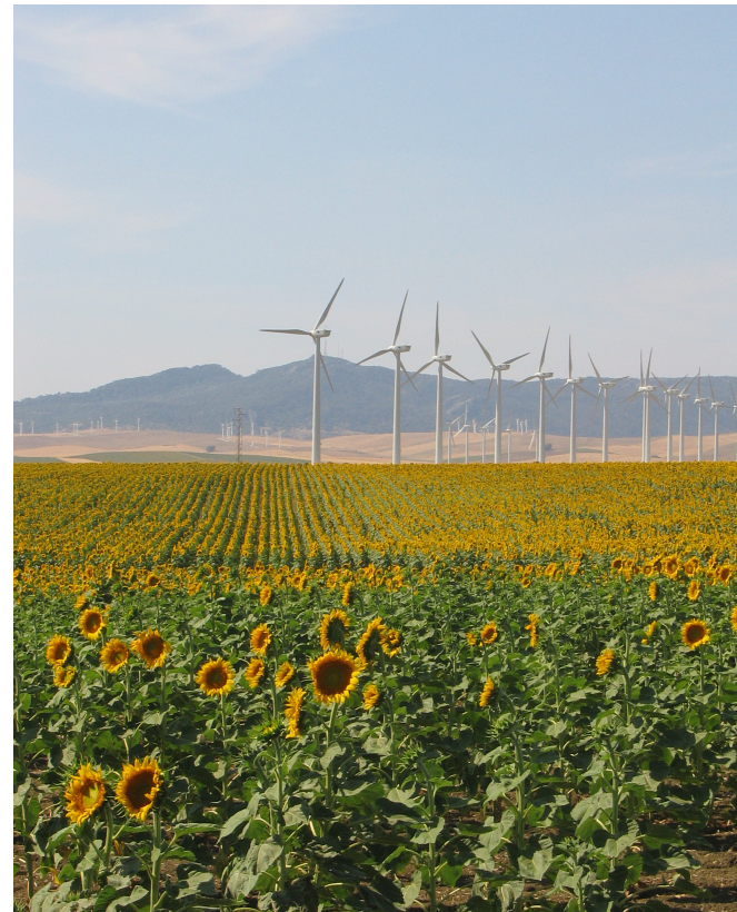
Aerogeneradores (alrededores de Tahivilla)
