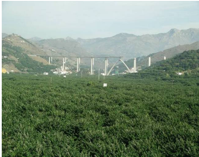
Viaducto de la A-7 en construcción
