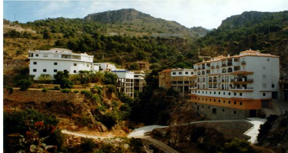
Edificaciones en las márgenes de un barranco en Otívar
