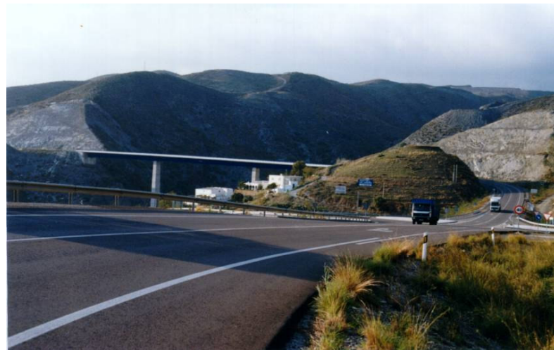
Viaducto de la N-340 en Castillo de Huarela (Albuñol)
