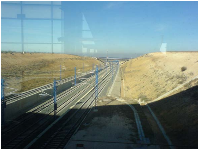
Vías ferrocarril AVE
