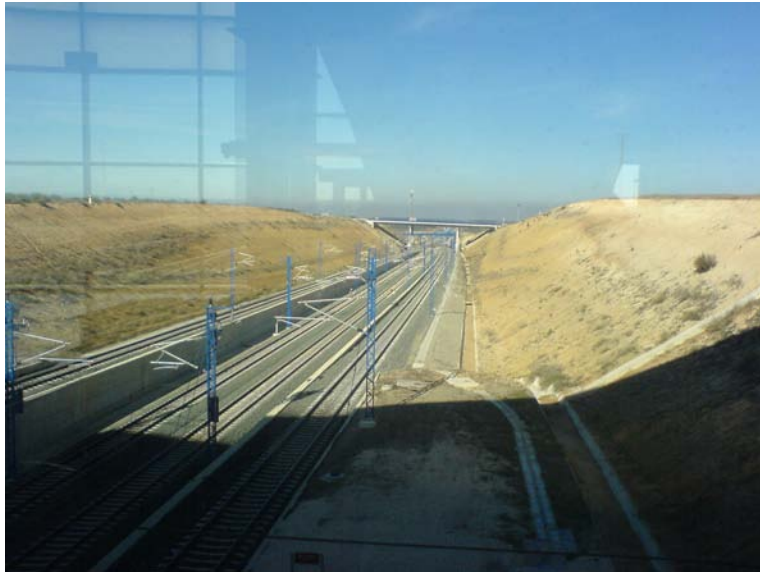
Vías ferrocarril AVE
