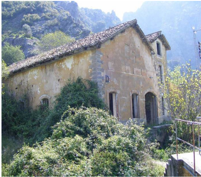
Central Hidroeléctrica de Valdepeñas de Jaén
