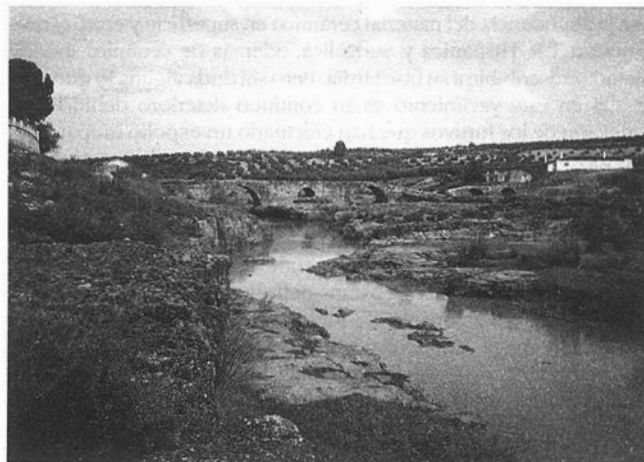
LAM. 5. "Puente Mocho". Puente Romano.
