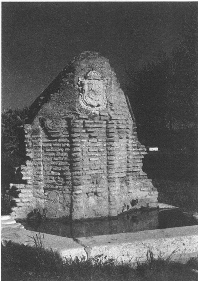
LAM. 23. Sector F. Km. 1 CO 122 Posadas. "Fuente Lejos" S. XVIII.
