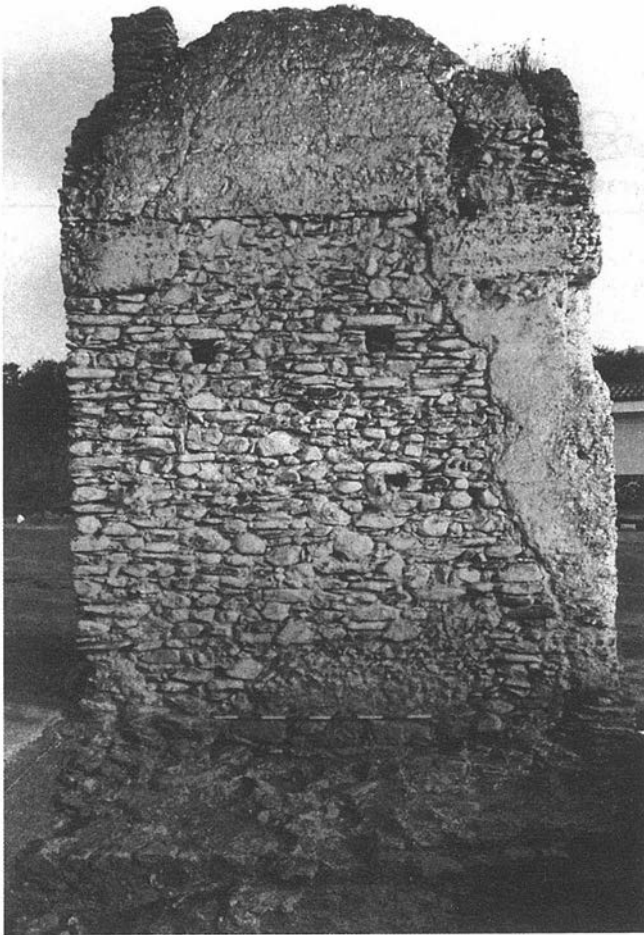
LAM. I. b. Fachada Sur. Obsérvese la restitución casi total del muro por debajo del cuerpo de la bóveda.
