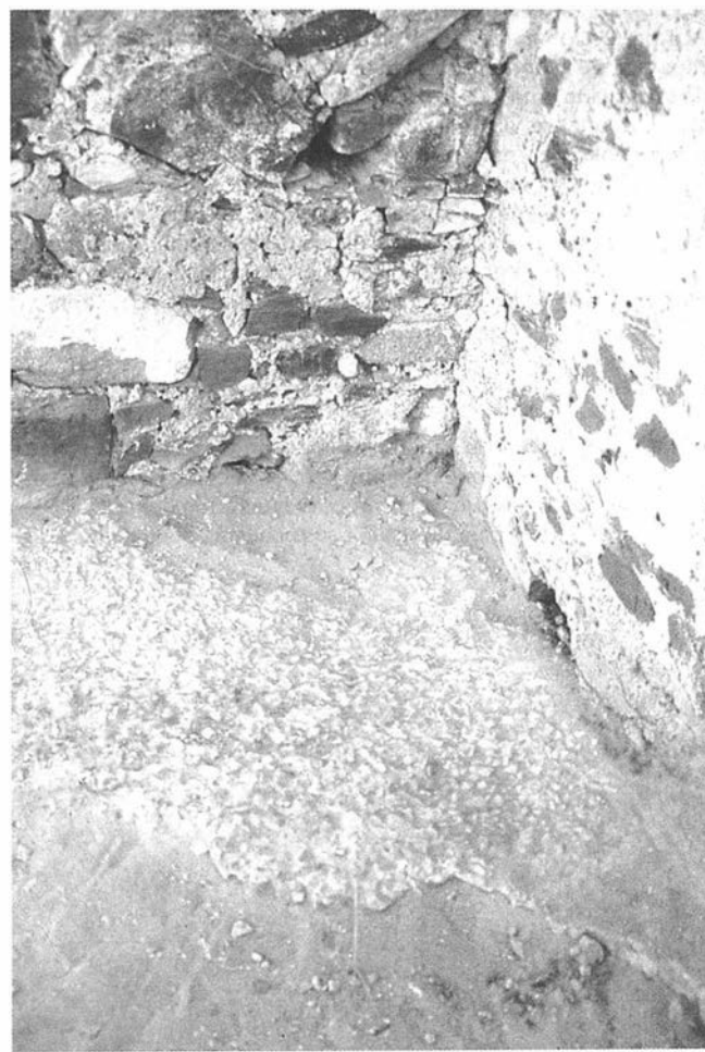
FOTO 7. Vértice N E y pavimento. Detalle del pavimento. FOTO 8. Fachada S. Fin de los trabajos.
