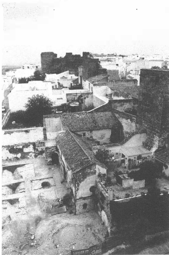
FOTO 1. Panorámica general de foso y muralla.
