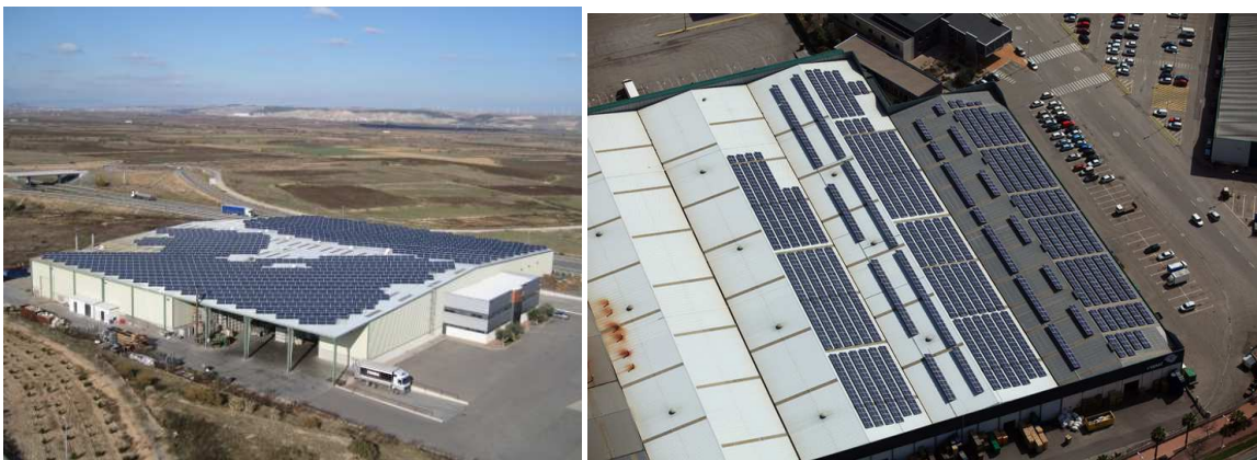
La disposición de las placas en diagonal provoca un mayor ruido visual en bordes
