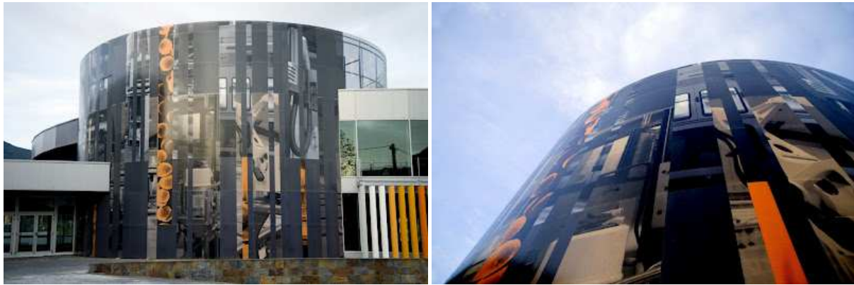
Tratamiento de fachada en nave industrial en Muskiz (Bizkaia) Estudio Ajuriaguerra Tres, como ejemplo de imagen de empresa atractivo estéticamente para la zona colindante a la A-7.
