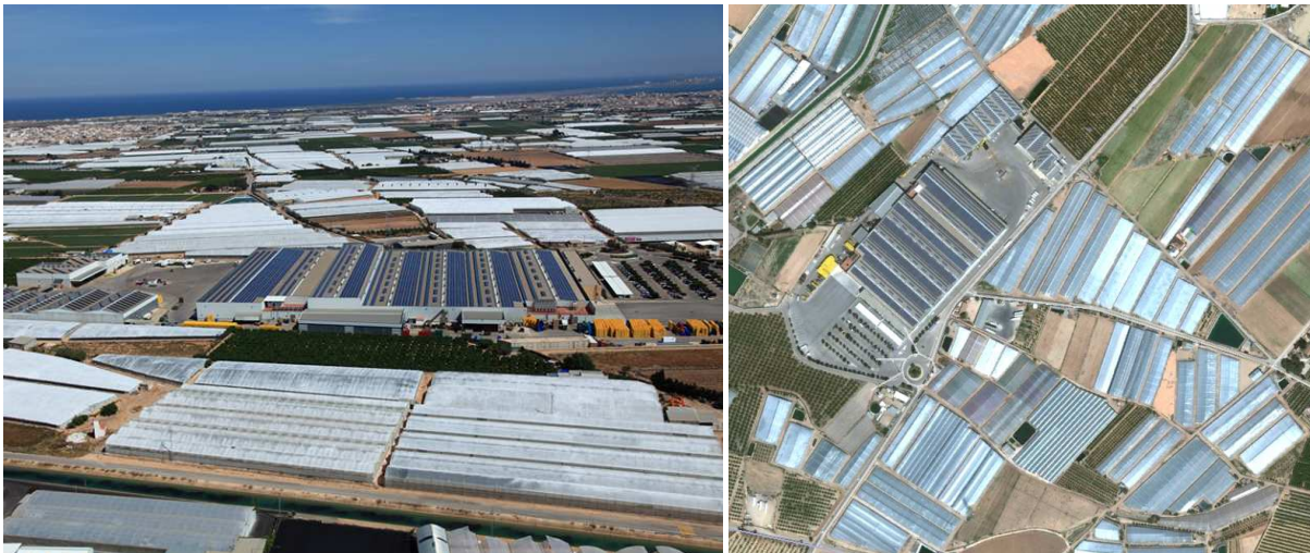
Integración de nave industrial con placas solares, invernaderos y campos de cultivo en Pilar de la Horadada (Murcia)
