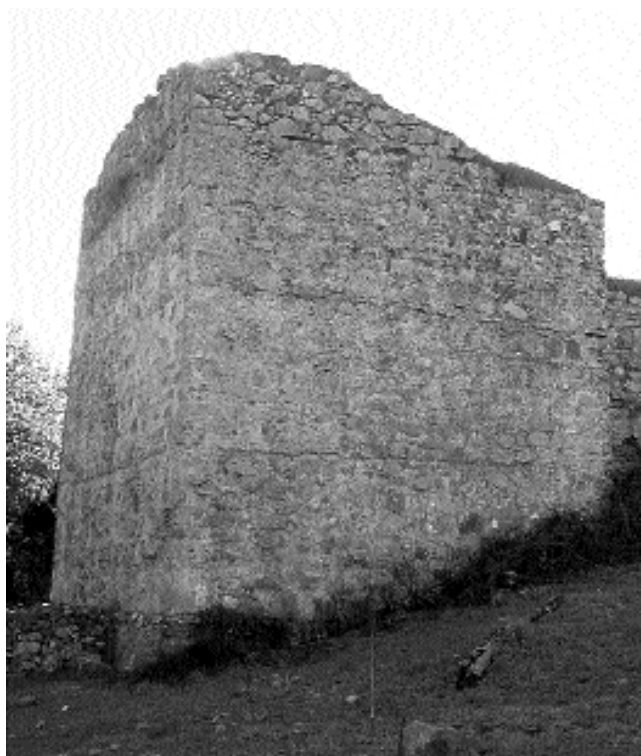
LÁM. III. Torre C.
