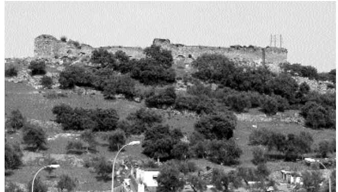
LÁM. I. Vista general del Castillo de Cala.
