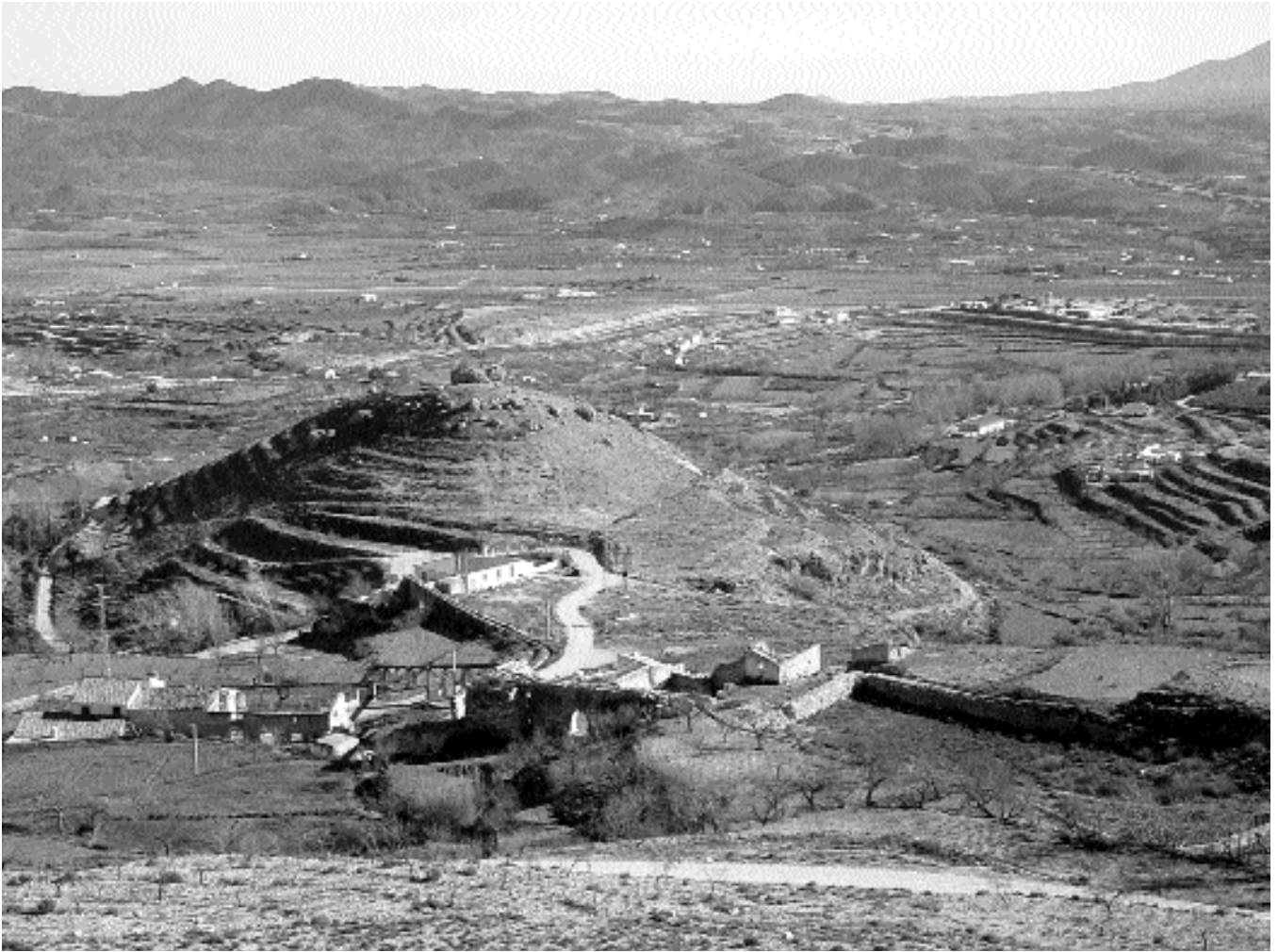
Fig.1. Panorámica situación general.
