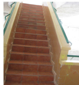
ESCALERA ACCESO 2ª PLANTA (ANTES)
