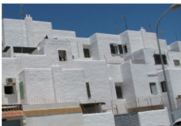
FACHADA SUR (DESPUES)
