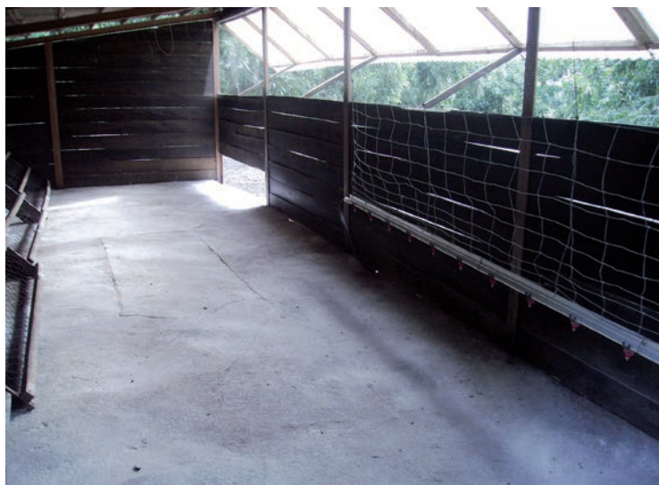
Nave en vacío sanitario (Foto cortesía Huerta Río Grande)
