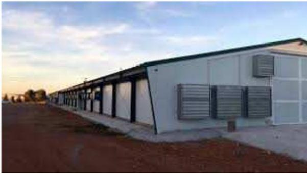
Para eliminar los sobreconsumos de las instalaciones de climatización y garantizar el confort térmico de los animales se deben evitar las entradas indeseadas de aire consiguiendo la estanqueidad de los cerramientos exteriores.
