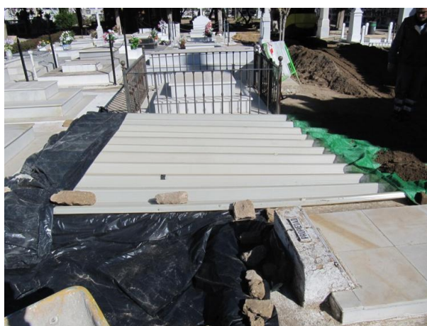
Cubrición y cerramiento provisional del depósito osteológico hallado en el Sondeo 10.
