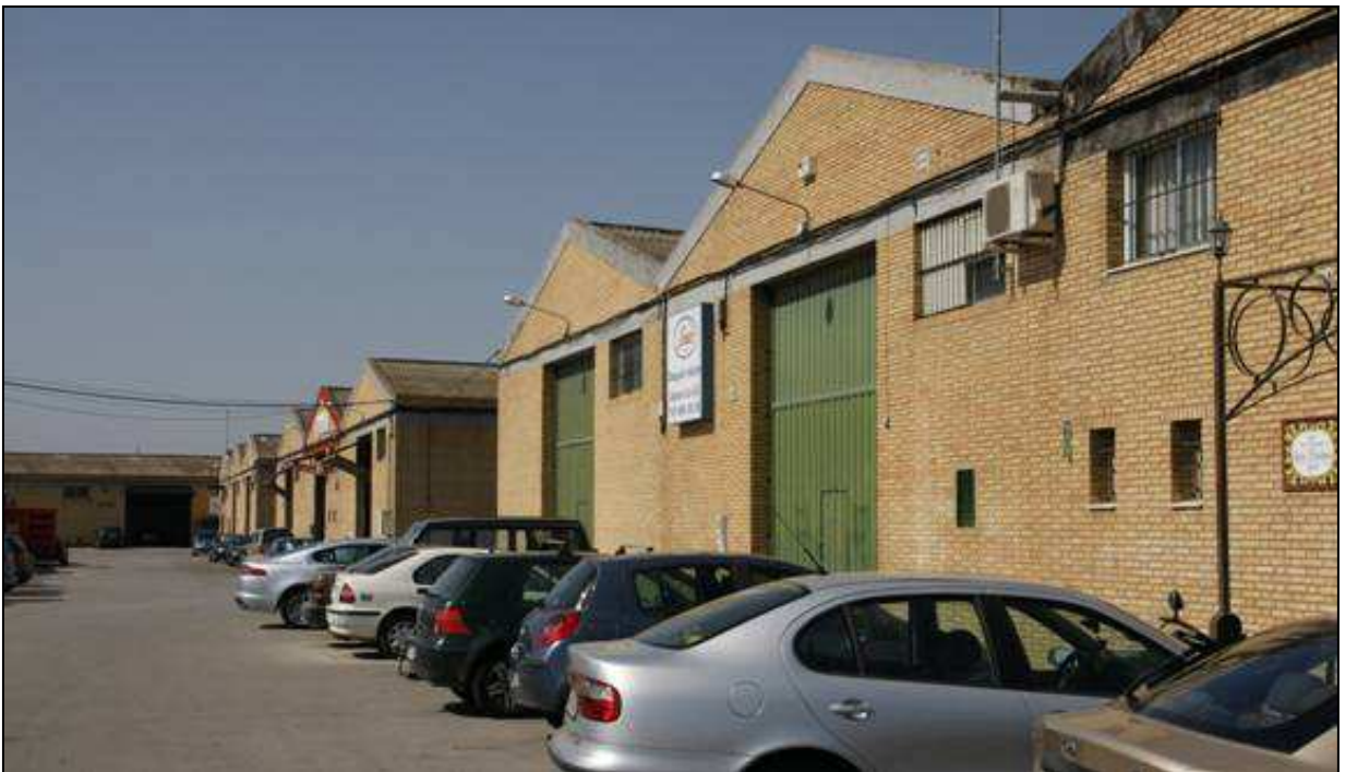
Polígono Industrial Majarabique
