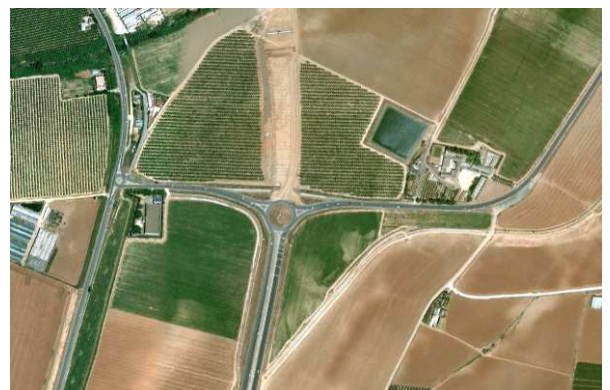
Nuevo Acceso Norte a Sevilla (A-8009), en su enlace con la carretera A-8004, y su prolongación hacia el norte en ejecución.
