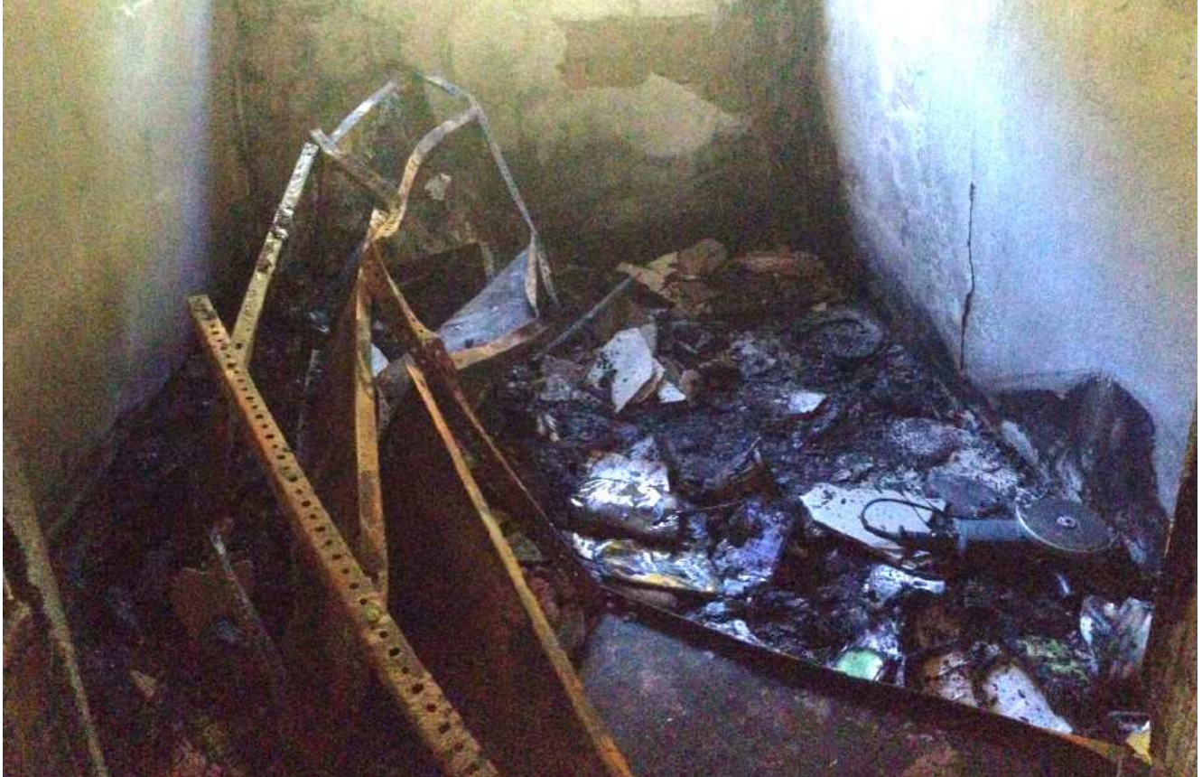
Imagen 1. Estado en el que quedó el local utilizado como almacén y archivo donde se produjo el incendio.
